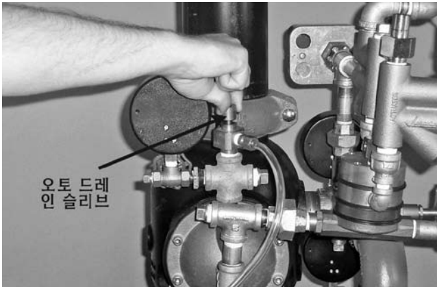
20. 스크류가 위로 향하는 위치에 이를 때까지 오토 드레인의 슬리브를 위로 올리십시오. 다이어프램 압력 전달관으로 가는 압력이 있는지 게이지를 통해 확인하십시오.
