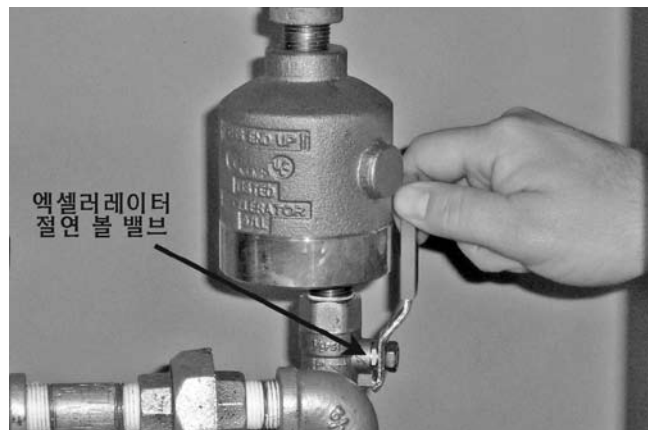
23. Series 746-LPA 드라이 엑셀레이터가 설치되면, 절연 볼 밸브를 여십시오. 절연 볼 밸브를 열면 엑셀레이터를 설정하게 됩니다.
