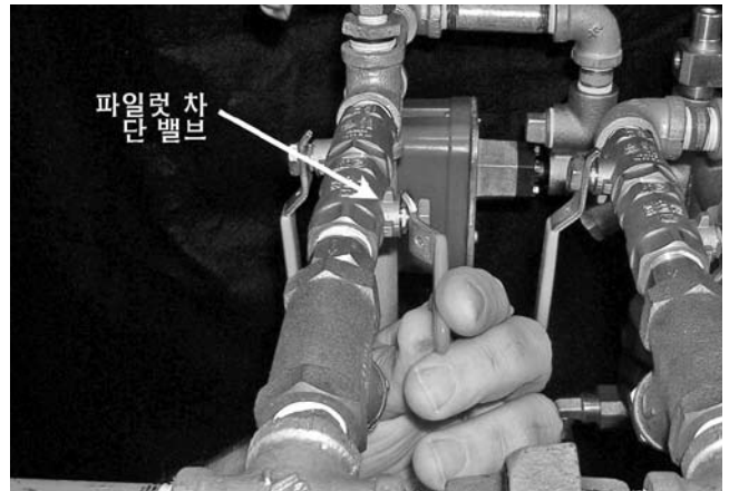
9. 파일럿 라인의 "SHUT-OFF" (차단) 밸브 (노란색 핸들) 를 닫으십시오.
