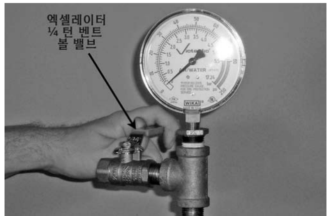
22. Series 746-LPA 드라이 엑셀레이터가 설치되면, 1/4-턴 밸브 볼 밸브를 닫으십시오.
