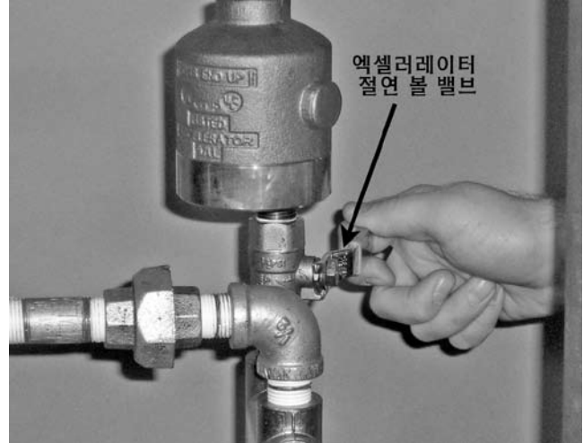
4. 시스템이 SERIES 746-LPA 드라이 엑셀레이터와 설치되는 경우: 엑셀레이터로 가는 절연 볼 밸브가 닫혀있는지 확인하십시오.
