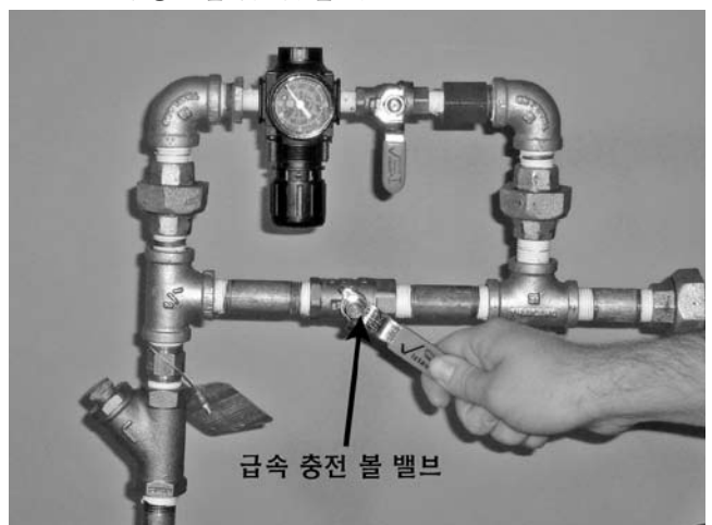
10. Series 757 에어 공급트림 어셈블리(에어 레귤레이터 부착형)의 급속충전 볼 밸브를 여십시오. 정상수준의 시스템 압력에 이를 때 까지 압력을 올리십시오.
