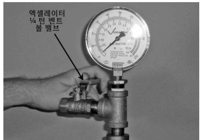
23. 시스템이 SERIES 746-LPA 드라이 엑셀레이터와 설치되는 경우: 엑셀레이터의 1/4-턴 벤트 볼 밸브를 닫으십시오.
