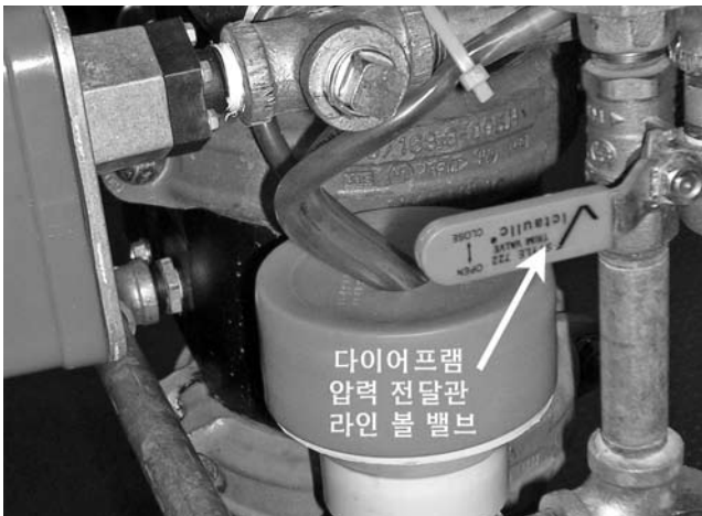
22. 다이어프램 압력전달관이 압력을 받고 있을 때, 다이어프램 압력 전달관의 볼 밸브를 일시적으로 닫아 주십시오. 다이어프램 압력 전달관의 압력 게이지를 살펴 다이어프램 압력 전달관의 압력이 유지되고 있는지 확인해 주십시오.
