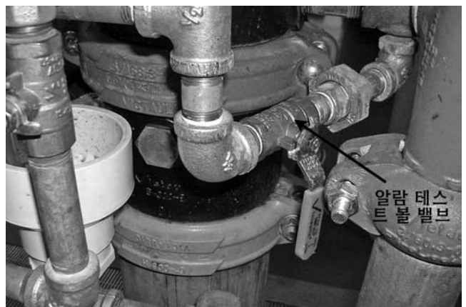
10. 경보 시험 볼 밸브가 닫혀 있는지 확인하십시오.
