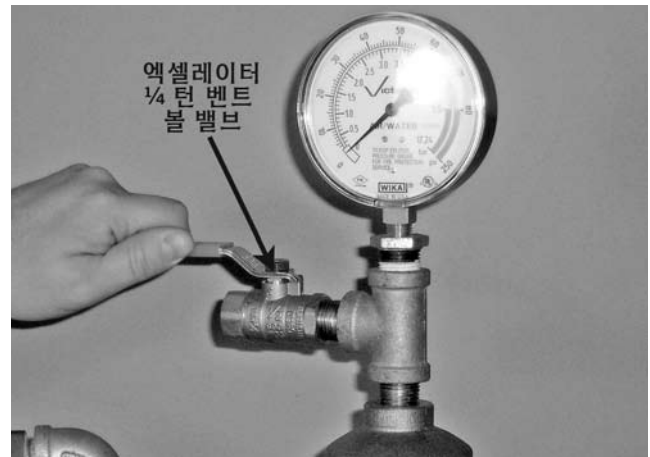
4a. 시스템이 SERIES 746-LPA 드라이 엑셀레이터와 설치되는 경우: 1/4-턴 볼 밸브를 여십시오.
