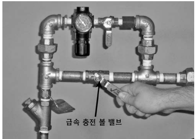
10. 경보 시험 볼 밸브가 닫혀 있는지 확인하십시오.
